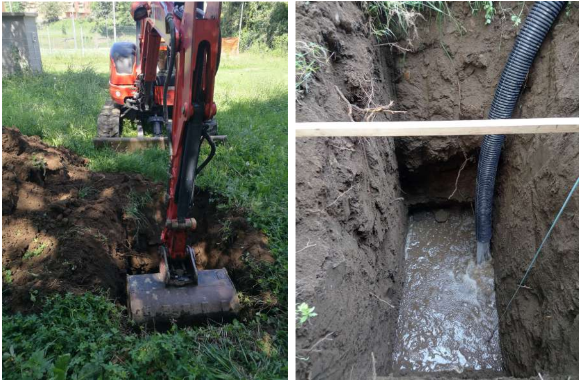
Fasi esecutive della prova di permeabilità
